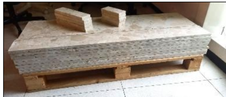
Marches après dépose et découpe
