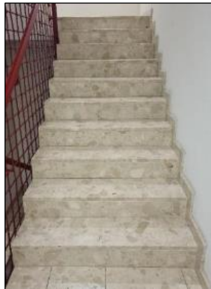
Escalier avant dépose
